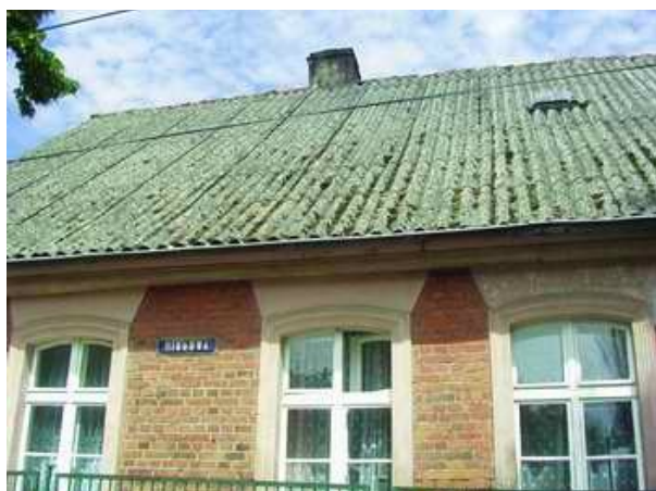
Pokrycie dachu eternitem:
